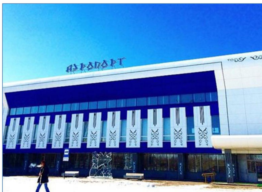
Современное здание Аэровокзала г. Абакана
